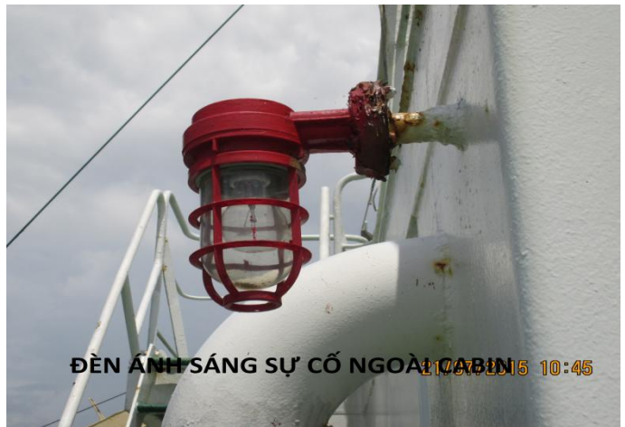
ĐÈN CHIẾU SÁNG SỰ CỐ KHU VỰC XUỐNG KHU VỰC XUỐNG CỨU SINH 21/07/2015 10:36
